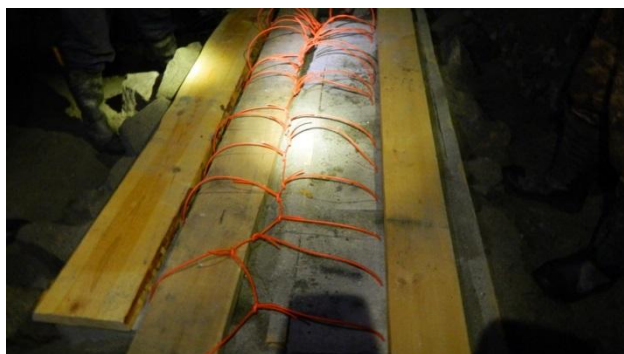
Рис. 1. Подготовленные к взрыву блоки
