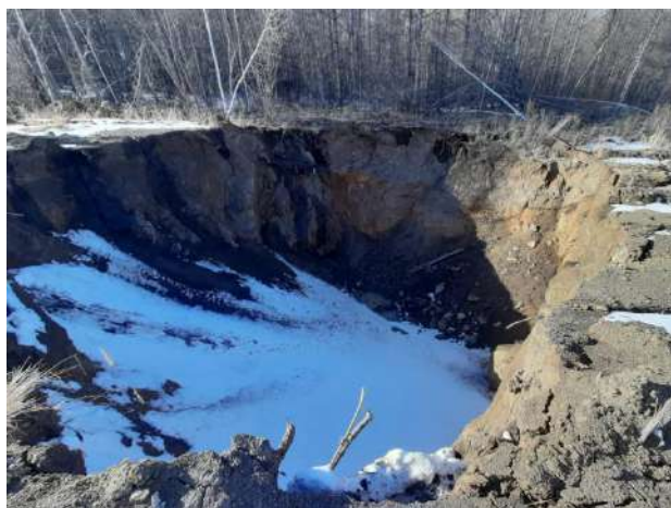
Рис. 3. Увеличение площади и глубины провала Fig. 3. Increasing the sinkhole area and depth
