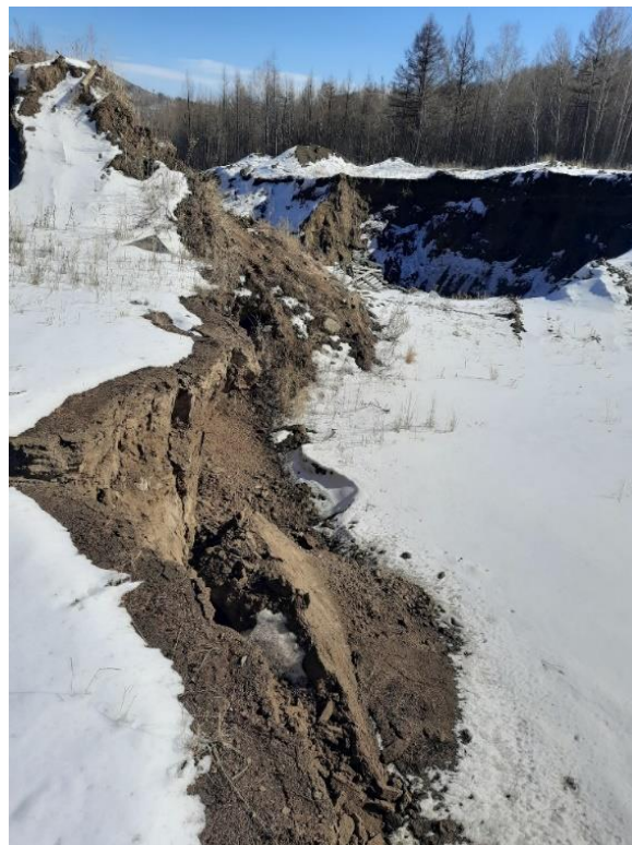
Рис. 1. Провал земной поверхности над участком «Южный»
