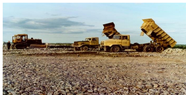
Рис. 3. Горнотехническая рекультивация хвостохранилища в карьере бурых железняков Fig. 3. Mining reclamation of the tailings dam in a brown iron ore quarry
