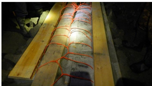
Рис. 1. Подготовленные к взрыву блоки
