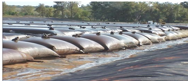
Рис. 2. Процесс обезвоживания пульпы
