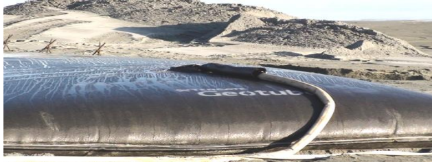
Рис. 1. Заполнение пульпой контейнера Geotub
